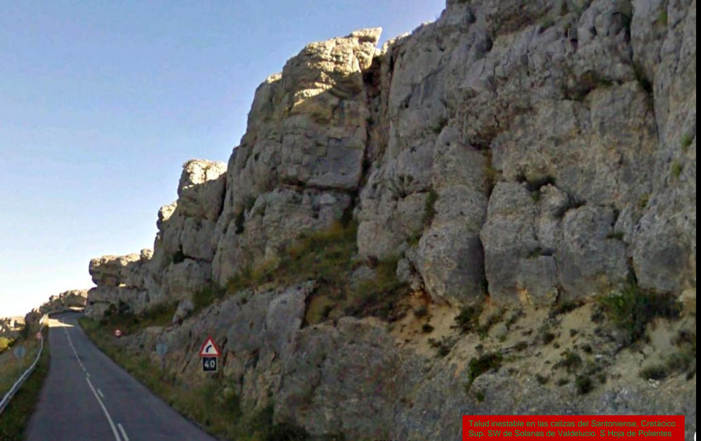
Talud inestable en las calizas del Santoniense, Cretácico Sup. SW de Solanas de Valdelucio. S Hoja de Polientes
